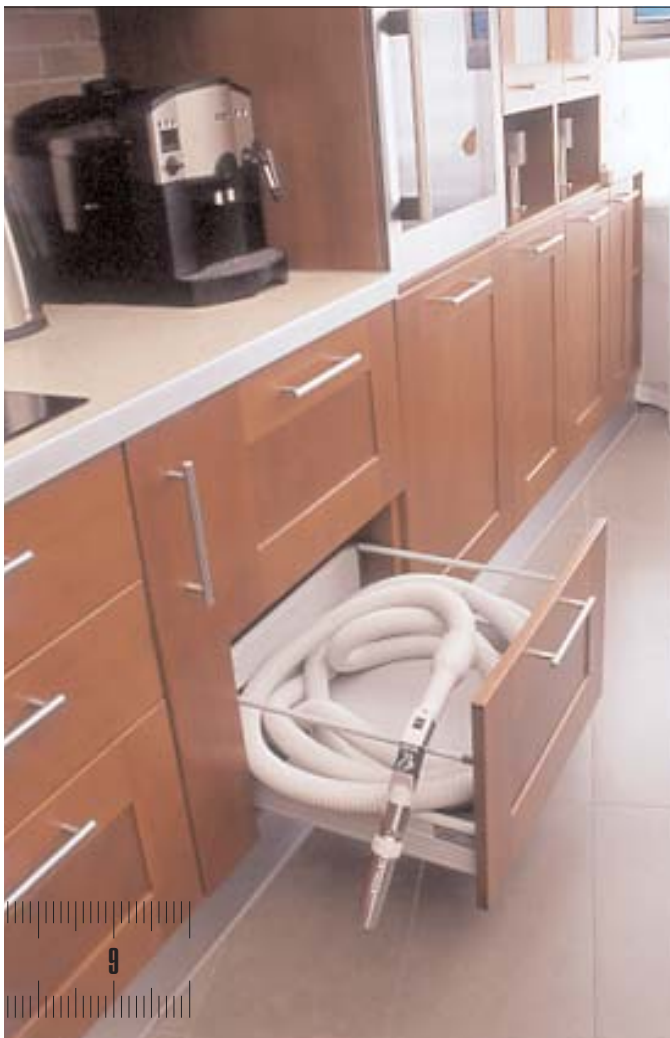
↓ На кухне пневморозетка, размещённая на стене за мебелью недоступна—выручит дополнительный шланг с выключателем, размещённый в ящике
